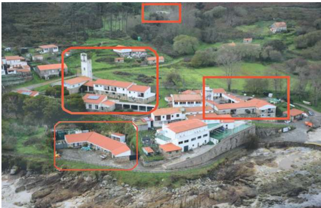
Barrio de Curro, onde Colonización construíu o Centro Cívico. Encadradas as edificacións realizadas.
