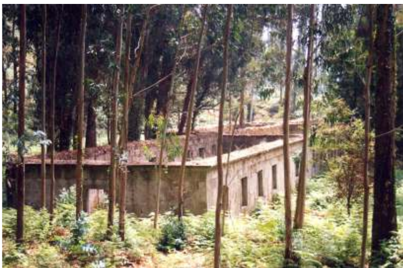
Restos do lazareto de Tambo que aínda se conservan na actualidade
