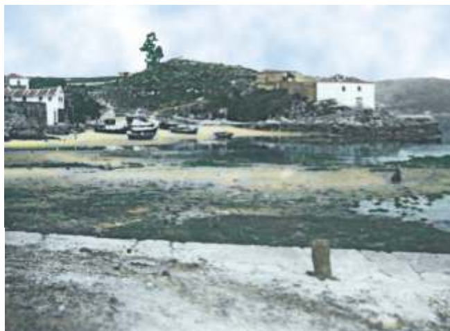
Emprazamento do Forte de Marín
