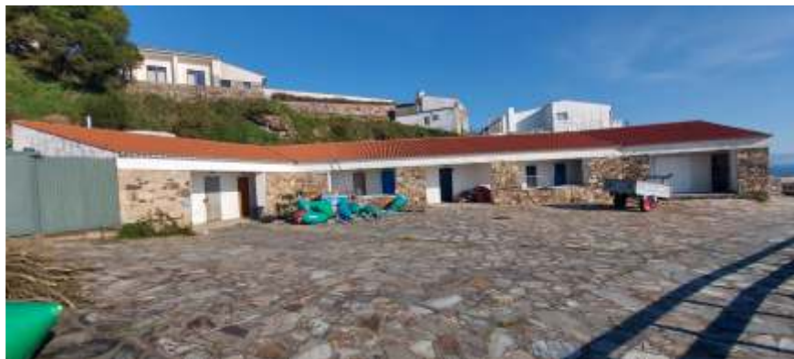
Zona onde estaba a canteira do muelle, hoxe casetas dos mariñeiros
