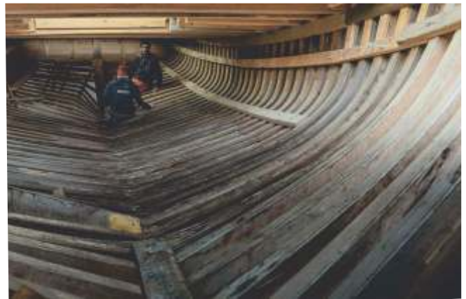
Interior dunha barcaza en construción
