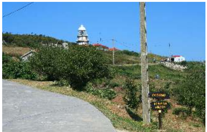
O Cucorno, barrio máis alto de Ons onde está ubicado o Faro
