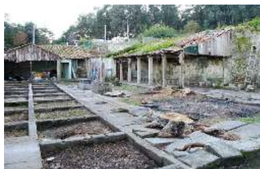
Estado antigo da instalación
