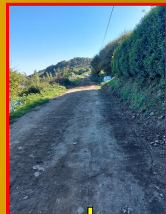
Primeira fase de soterramento dos cables eléctricos.
