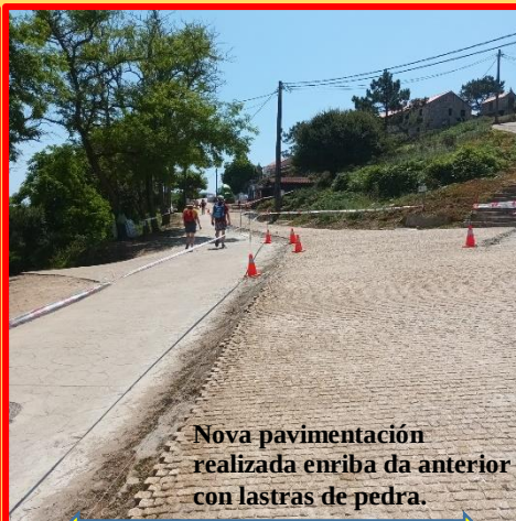
Perfecto estado do pavimento da rúa principal. Por que cambialo?
