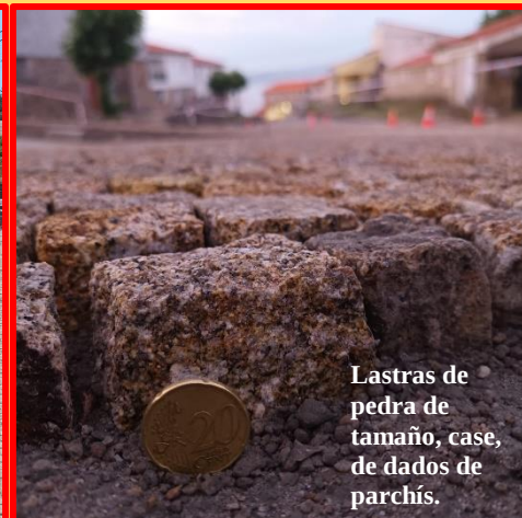
Nova pavimentación realizada enriba da anterior con lastras de pedra.
