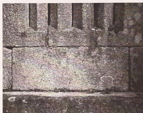
Fig. 14. O "testeiro" baixo as "pedras caladas" do "penal" e sobre o "tornarratos".
