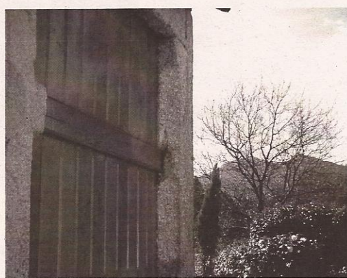
Fig. 10. As "columnas" de pedra que estruturan os costais.
