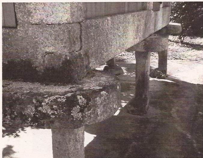
Fig. 5. A "grade", que é o conxunto de "traves", tornarratos" e "pés".
