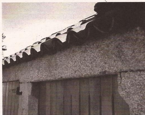
Fig. 13. A "soleira" sobre as "columnas", baixo o "tallado", rematando por riba o "costal".
