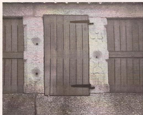
Fig. 12. A "porta" co "dintel" e os "portais de pedra" (xambas) apoiados sobre o "xugo".
