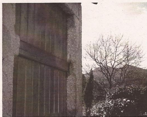
Fig. 10. As "columnas" de pedra que estruturan os costais.
