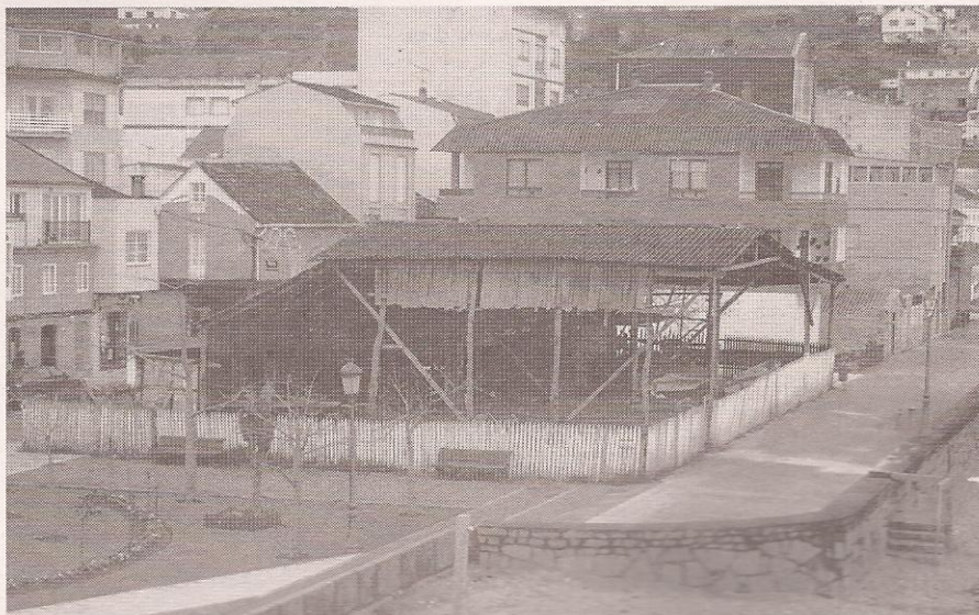
Foto: Estaleiro de Purro
