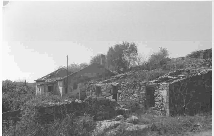
Casas que ían quedando deshabitadas a finais dos anos 60 e que as inclemencias do tempo na Illa, provocaba o seu rápido deterioro. A falla dun peirao e servizos básicos, obrigou a formar unha nova vida en terra
