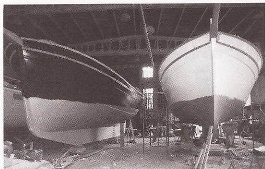
Foto 8: Galeóns en construción
