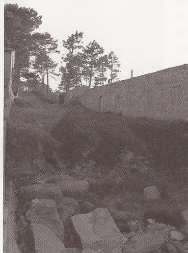
Camión erosionado onde tamén se depositaron armas.
