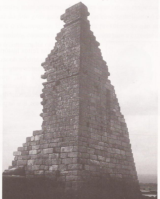
Torre de San Sadurniño. Cambados
