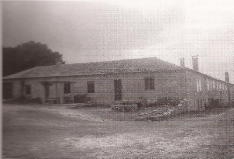
Antiga salgazón do Carreiro infraestrutura comercial, pois a salgazón era unha das producións galegas máis importantes séculos atrás.
